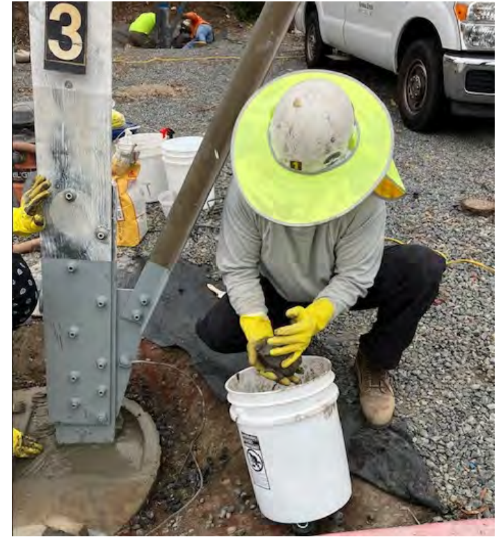
Mortar Infill
